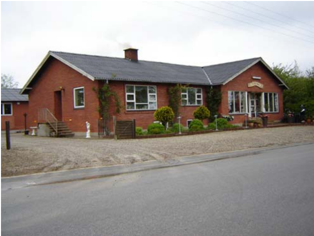
Systemen er etableret i den " Gamle Brugs "
