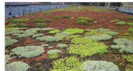
Fig. 89: Et grønt tag optager i gennemsnit 50 procent af nedbøren, som falder på taget.
