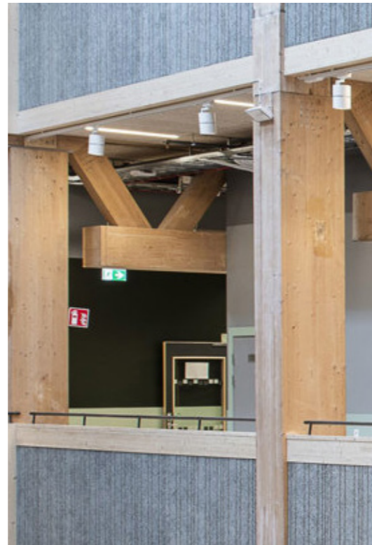
Spots på skinne monteret på konstruktion
