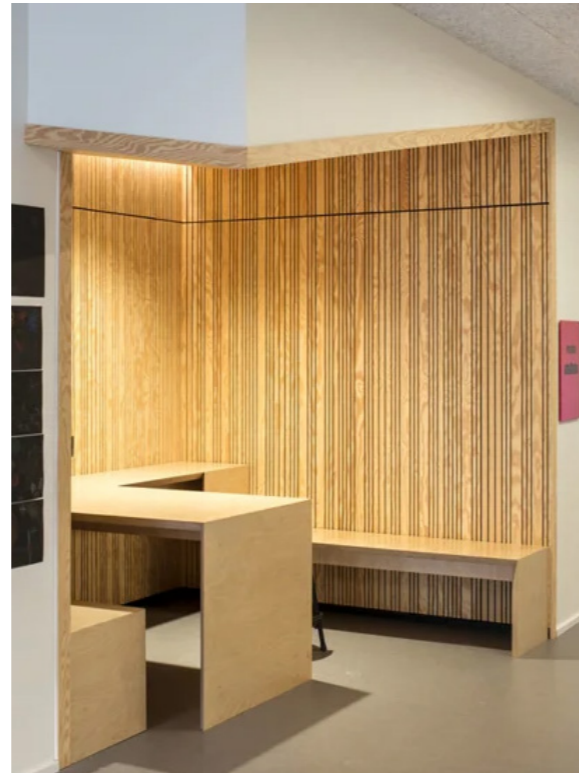
Integreret, indirekte linjelys i nicher
